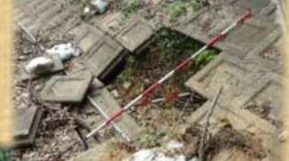
張ブロックの損傷（堤体土流出）
