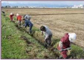
水路の泥上げ
