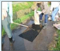
農道の部分補修
