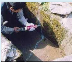
ひび割れの補修
