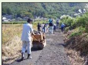
未舗装農道の舗装
