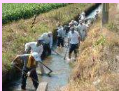
水路の泥上げ
