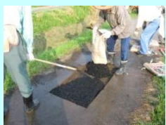
農道の部分補修
