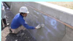
老朽化した水路壁のコーティング
