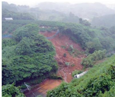
法面崩壊状況
