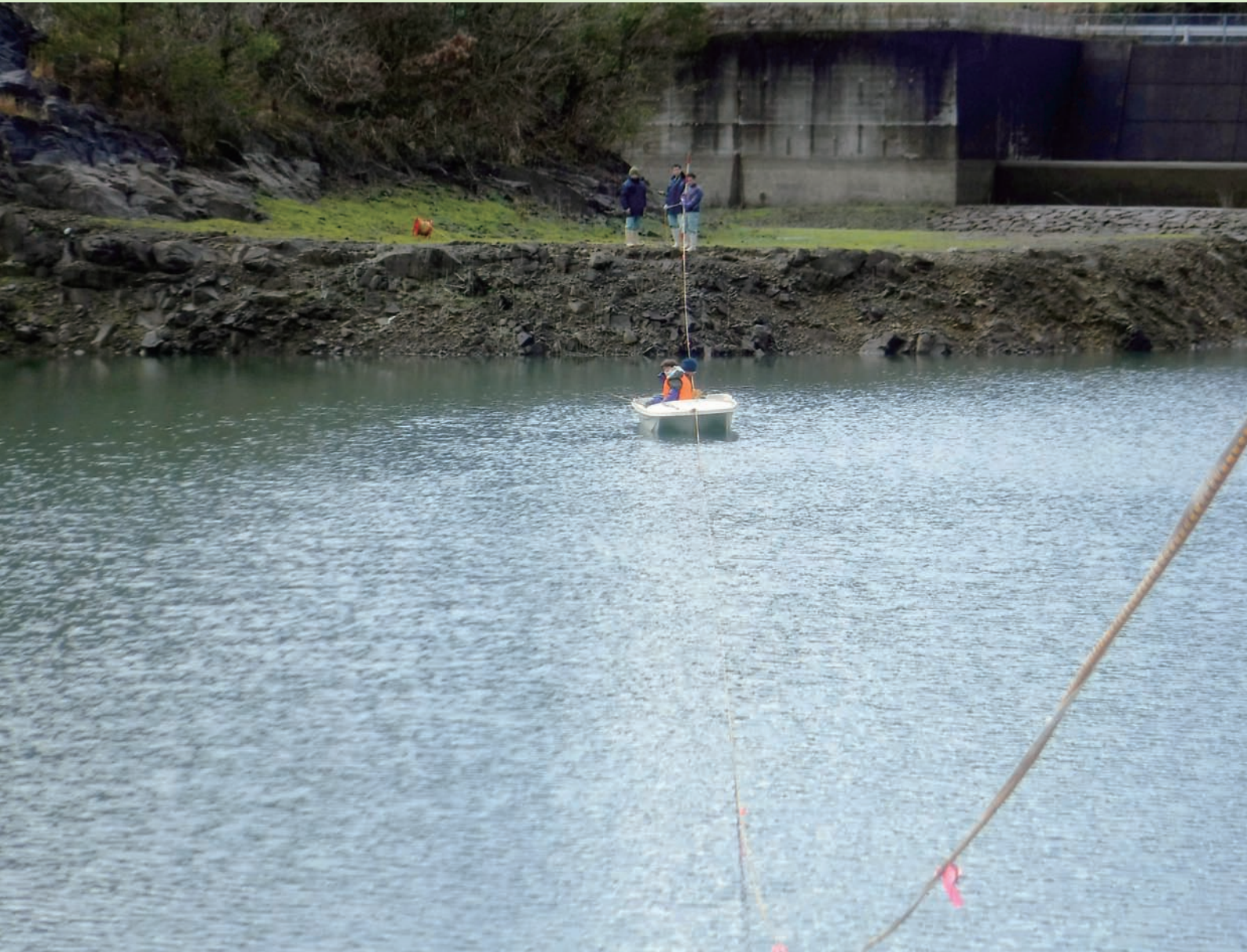
[写真] 古木場ダム (有田町) の堆砂測量
