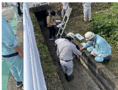
【開水路の診断状況】
