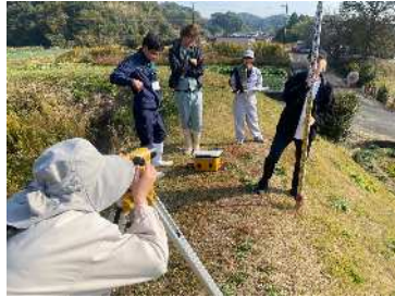
外業(ため池堤体測量)の様子
