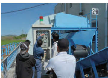
新村排水機場
