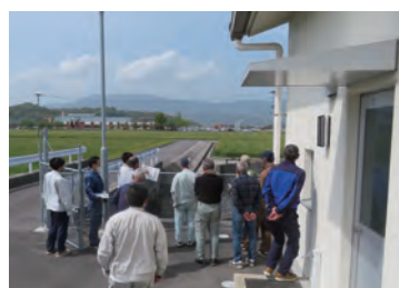
前満江第二排水機場
