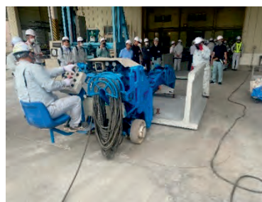
リフトローラー工法
